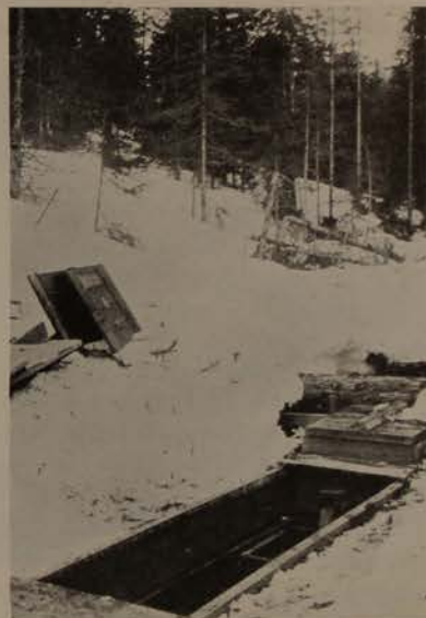
Fig. 1. Undre anläggningen. Ytter- och innerlådor synliga, dessutom en kalifornisk kläckningslåda med vattentillopjet. (Förf. foto 12/3 1920.)
