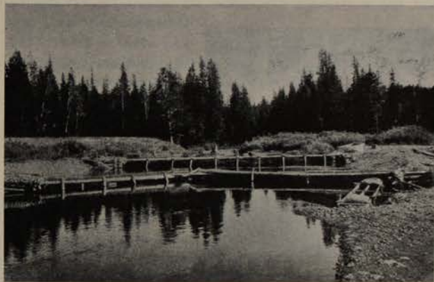
Fig. 4. I flodmynning före leken uppbyggda fångstinrättningar, avsedda för fångst av avelsfisk (laxöring, bäckröding etc.).
