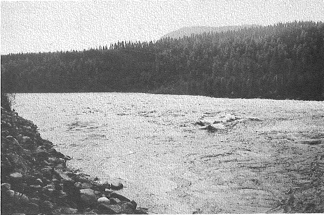
Figur 3. Den övre delen av Gammelängemagasinet, Indalsälven, strax nedströms tunnelutloppet från Krångede kraftverk. Foto: J Henricson.
