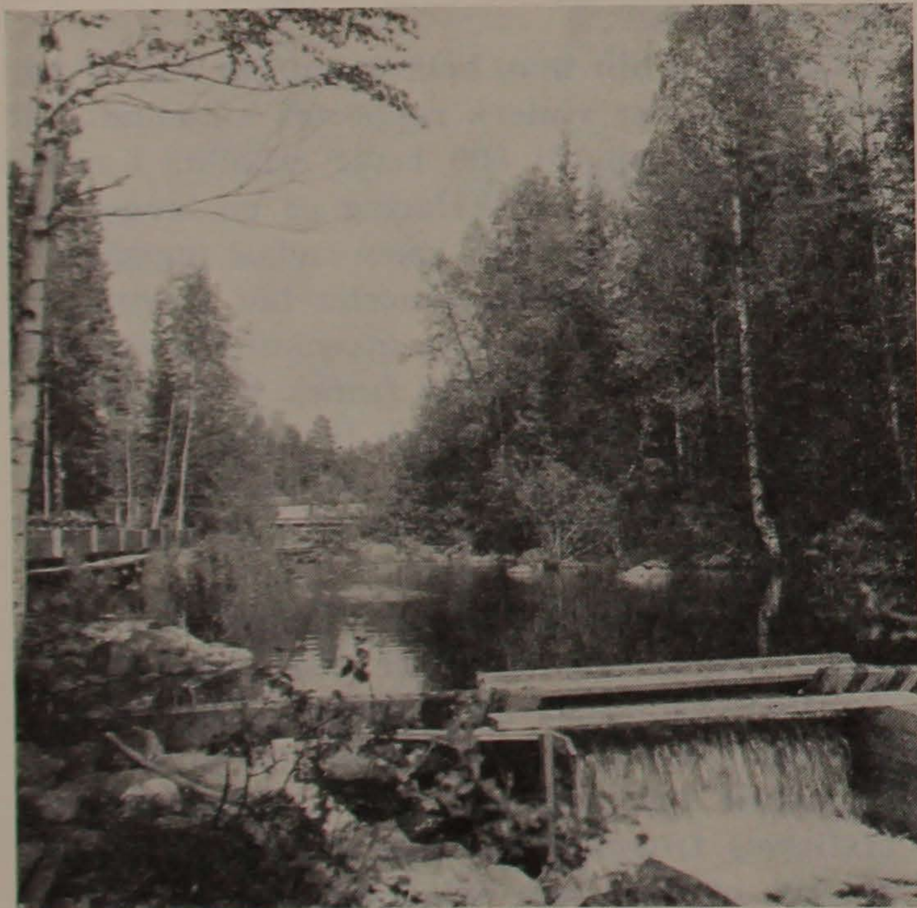
Vindel-dammen. Det breda utloppet jämte regleringsanordningar vid inloppet förhindra högvattensskador.
