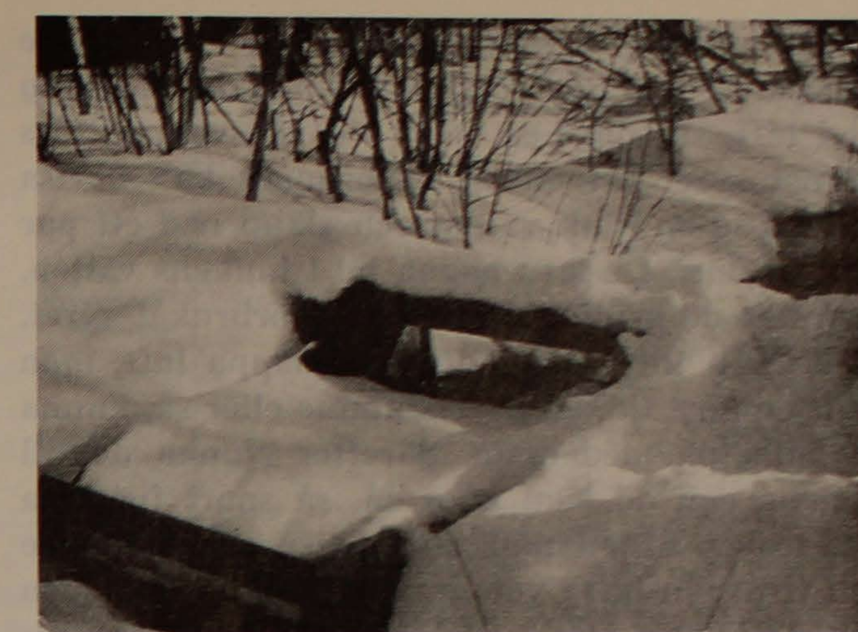
Bild 2. Luftningsanordningarna upphöra ej att fungera under vintern. De bli blott översnöade, men frysa ej igen.
